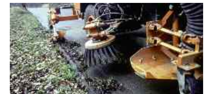
Regelmässiges Wischen und Abranden verlängern die Lebensdauer der Bausubstanz und verhindern unerwünschten Bewuchs.
