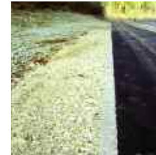
Nährstoffarme Bankette enthalten Kies und Sand oder Mergel. Das Material sollte auf die umgebende Landschaft abgestimmt sein.
