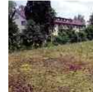
Bei der abgebildeten Dachfläche beträgt die Stärke des Substrates weniger als 5 cm. Problempflanzen sterben im Hochsommer ab. Es entsteht ein für spezialisierte Tier- und Pflanzenarten sehr wertvoller Lebensraum.
