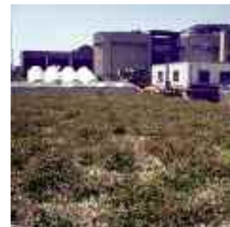
Die meisten Kläranlagen des Kantons BL sind naturnah gestaltet. Damit ist wertvoller Lebensraum für die heimische Tier- und Pflanzenwelt entstanden. Der Aufwand für den Unterhalt der Grünflächen der ARA's ist auf diesen grossen Anlagen gegenüber konventioneller Gestaltung um das vier- bis fünffache geringer.
