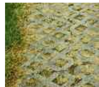
Rasengittersteine sind nur sinnvoll, wo Bewuchs toleriert wird. In solchen steilen Lagen kommt es ohne Bewuchs zu Erosion und Ausschwemmungen der Steine.
