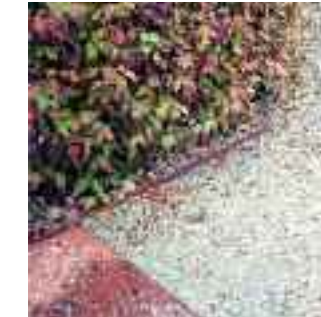
Die versenkte Eisenplatte verhindert die Ausbreitung des Wurzelwerks in den Wegkoffer.
