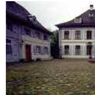
In historischen Anlagen ist Bewuchs oft unerwünscht. Auf dieser Pflästerung wird er toleriert, was wohl dem ursprünglichen Zustand eher entspricht.
