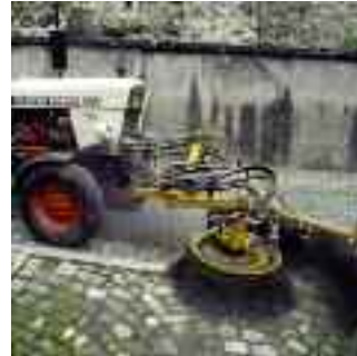
Jätbesen reissen Pflanzen mit der Wurzel aus. Ihr Einsatz ist sinnvoll bei schwerem, hohem Bewuchs, d.h. wenn jahrelang nichts unternommen wurde. Nach dem Einsatz müssen die Fugen saniert, resp. bei Pflästerungen muss neu eingesandet werden. Ist die Bausubstanz gut und wurde regelmässig gewischt, erübrigt sich diese Methode.
