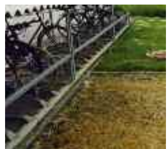
Verbotener Herbizideinsatz auf einem Parkplatz. Diese durchlässigen Beläge lassen Schadstoffe leicht ins Grundwasser versickern. Bewuchs entsteht nur dort, wo zu wenig genutzt wird. Durch Mähen (hochgestellter Mäher) kann er kontrolliert werden.
